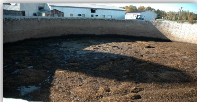
Gülesilo des Betriebs
