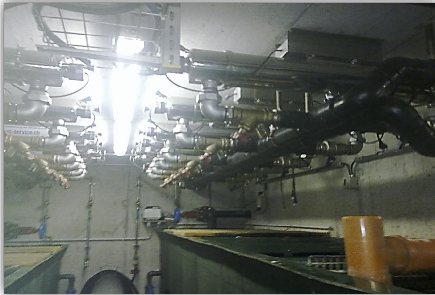
Bild 1: UV-Desinfektionsanlage und Reinigungsbecken im Technikkeller
