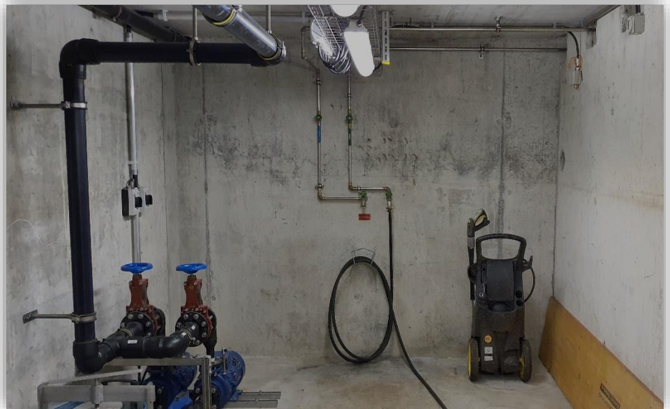
Bild 2: Technikkeller nach Entfernung der konventionellen Wasserreinigung
