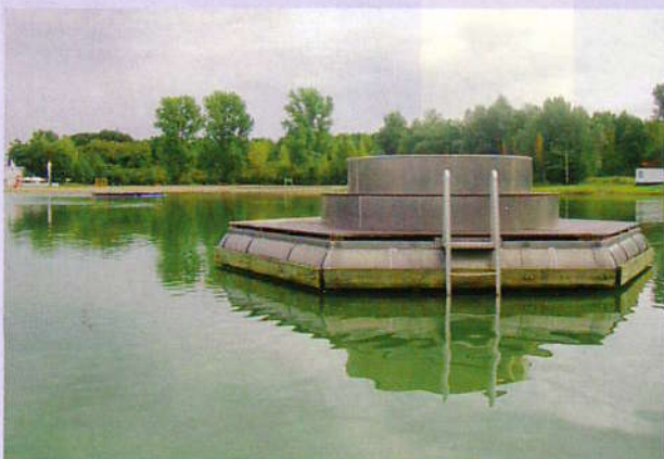
Gernsheimer Badesee: Die wirkungslose Tiefenbelüftung wurde zur Badeinsel umfunktioniert.
